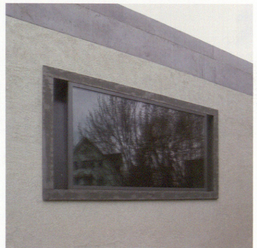
Ejemplo de carpintería metálica utilizada. Example of the metalwork used.
